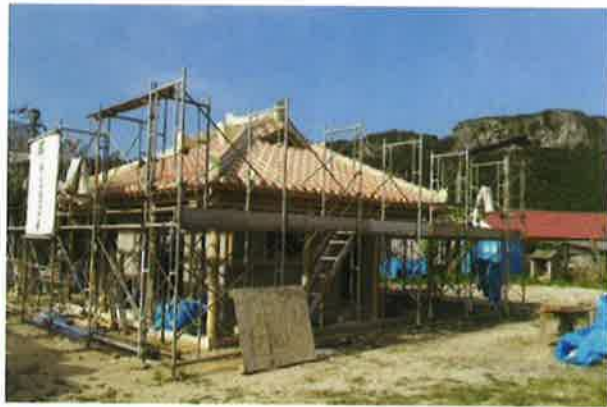
建て替え工事中の十山うがん
