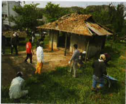
屋根瓦を降ろし終えた本殿
