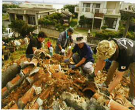
瓦を一枚ずつ丁寧に手作業でおろすボランティアの方々
