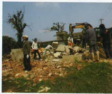
重機を使用しての本殿解体
